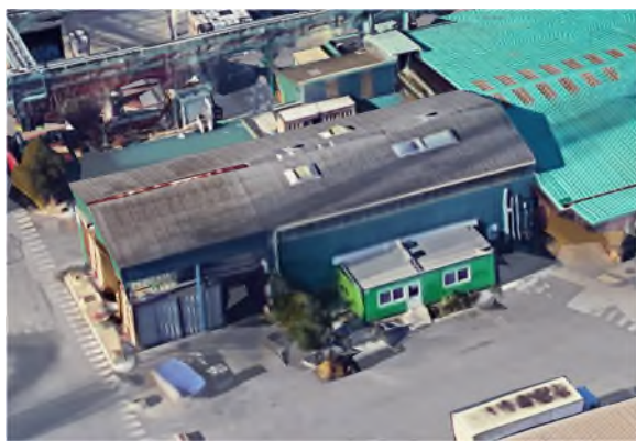
Photographie 4 : Zoom sur le bâtiment DTQD
