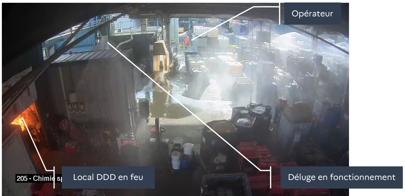
Photographie 18 : Image de la même caméra. Par rapport à la photographie précédente, on note que l'incendie a gagné en intensité, la quantité d'eau épandue a augmenté et le système d'extinction sous l'auvent s'est déclenché
